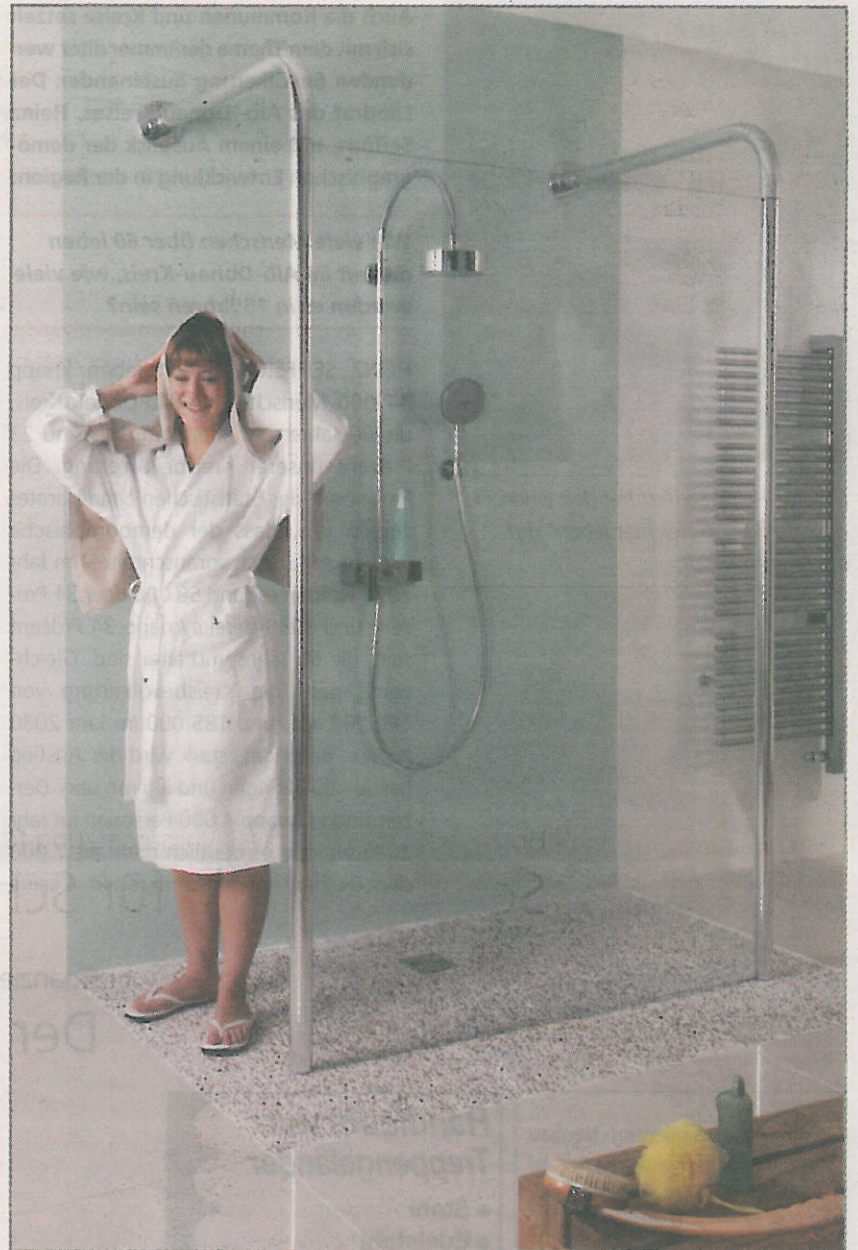
Bodenbündig eingebaute Duschen gewährleisten einen sicheren Ein- und Ausstieg.
